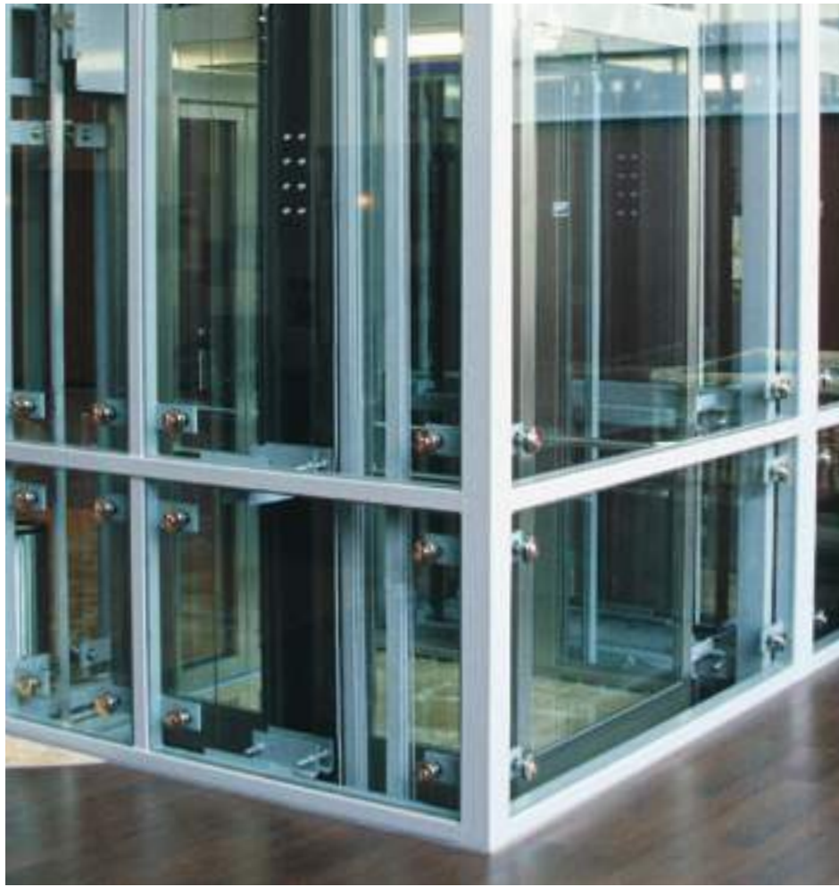
Rohrschachtgerüst Quadratrohr Glasbefestigung Punkthalter, Verglasung zwischen den Profilen
