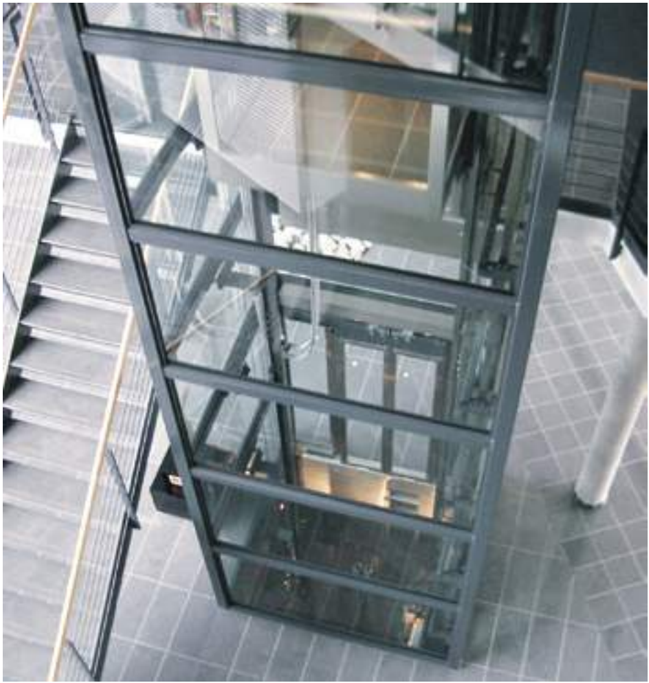
Rohrschachtgerüst Quadratrohr Verglasung zwischen den Profilen
