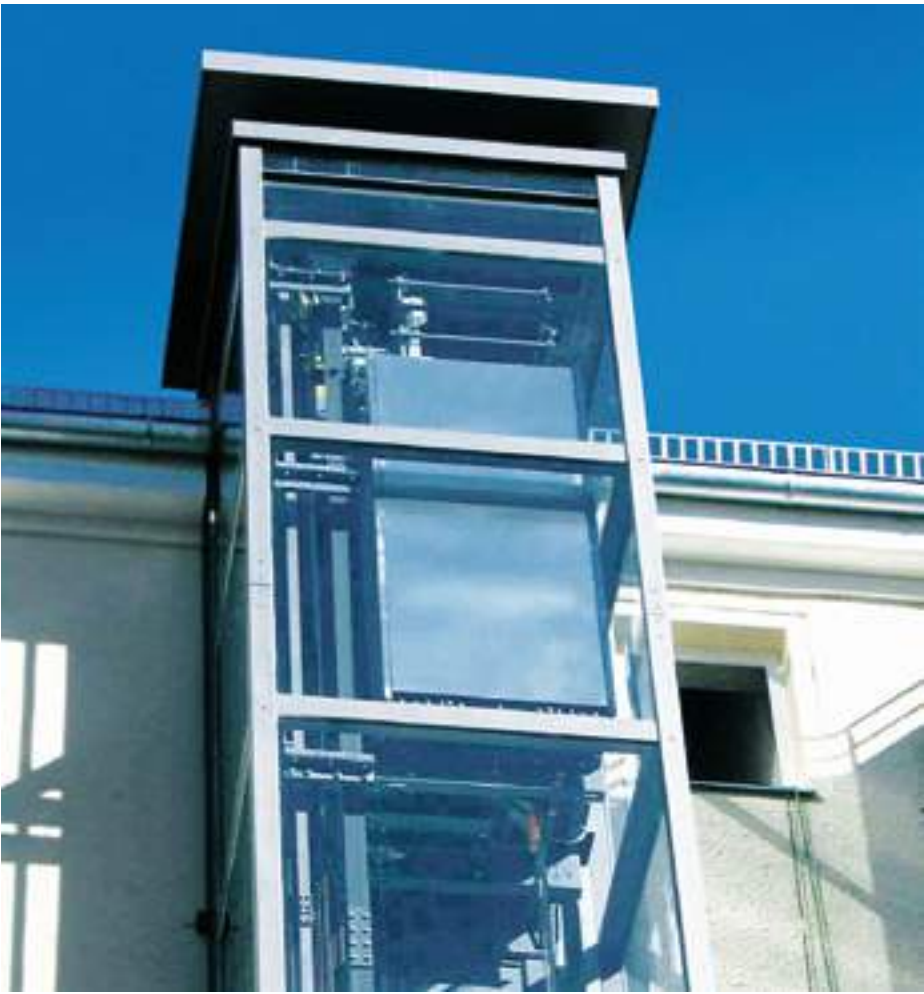
Winkelschachtgerüst Winkel Innen
